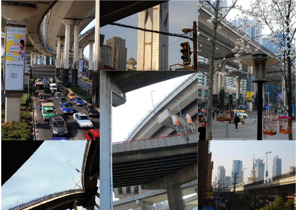
Hochstraßen im Stadtzentrum
